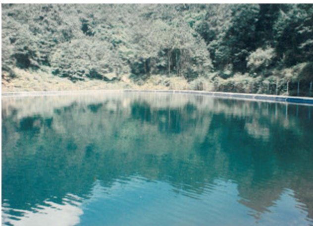
阿里山蓄水池整建工程
